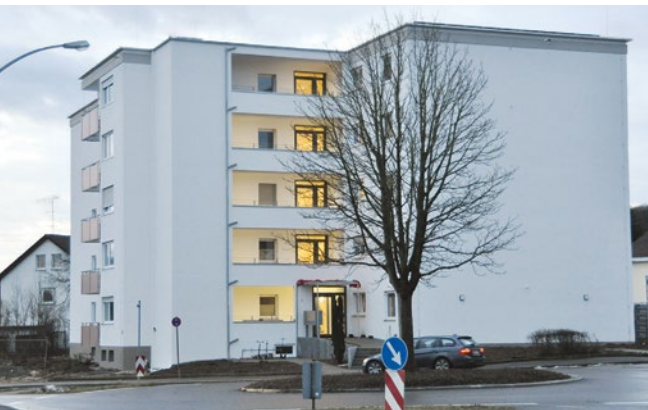
Akkermanstraße 3 in Göppingen: Angebauter Aufzug mit Laubengang zum Treppenhaus
